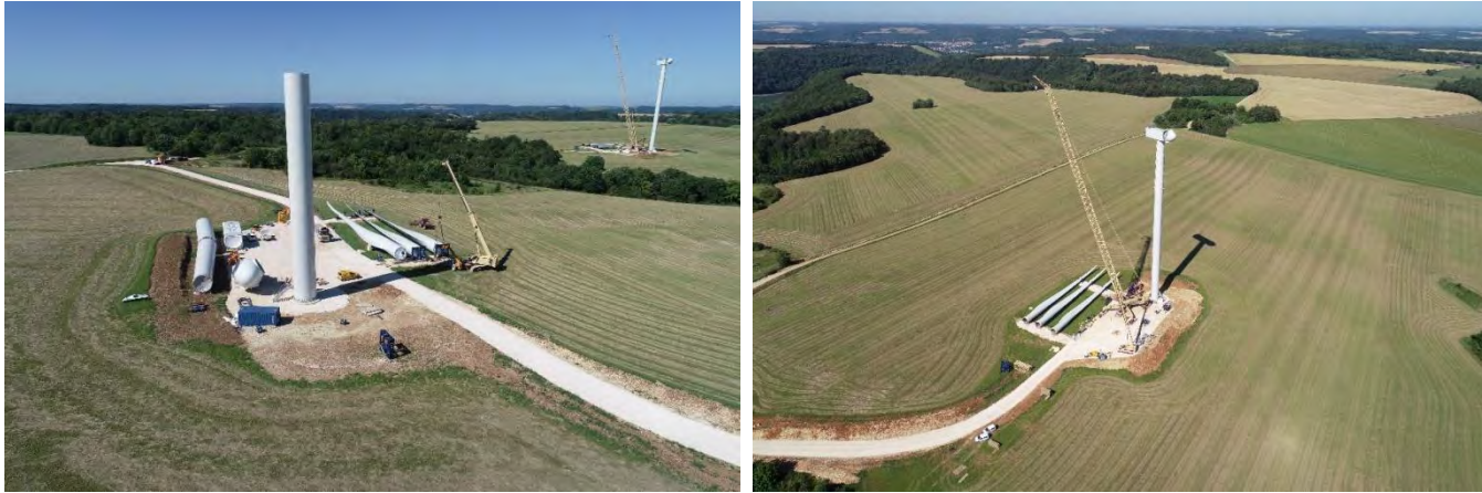
Photo 2 : Exemple de montage des éoliennes – Parc éolien de Piroy (Source : CALYCE DEVELOPPEMENT)
