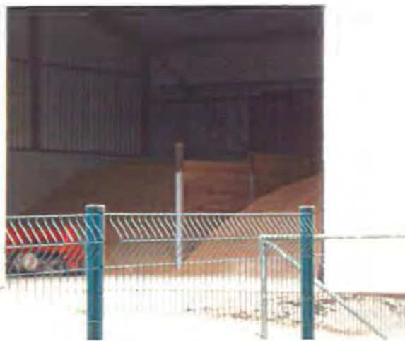
Bâtiment de stockage de grains
