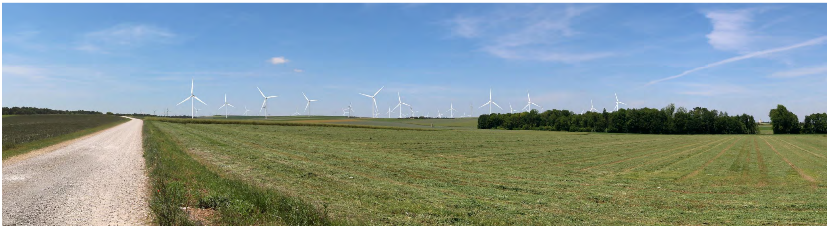
Photo 6 : Insertion du projet dans son environnement en vue proche (Source : BE Jacquél et Chatillon)
